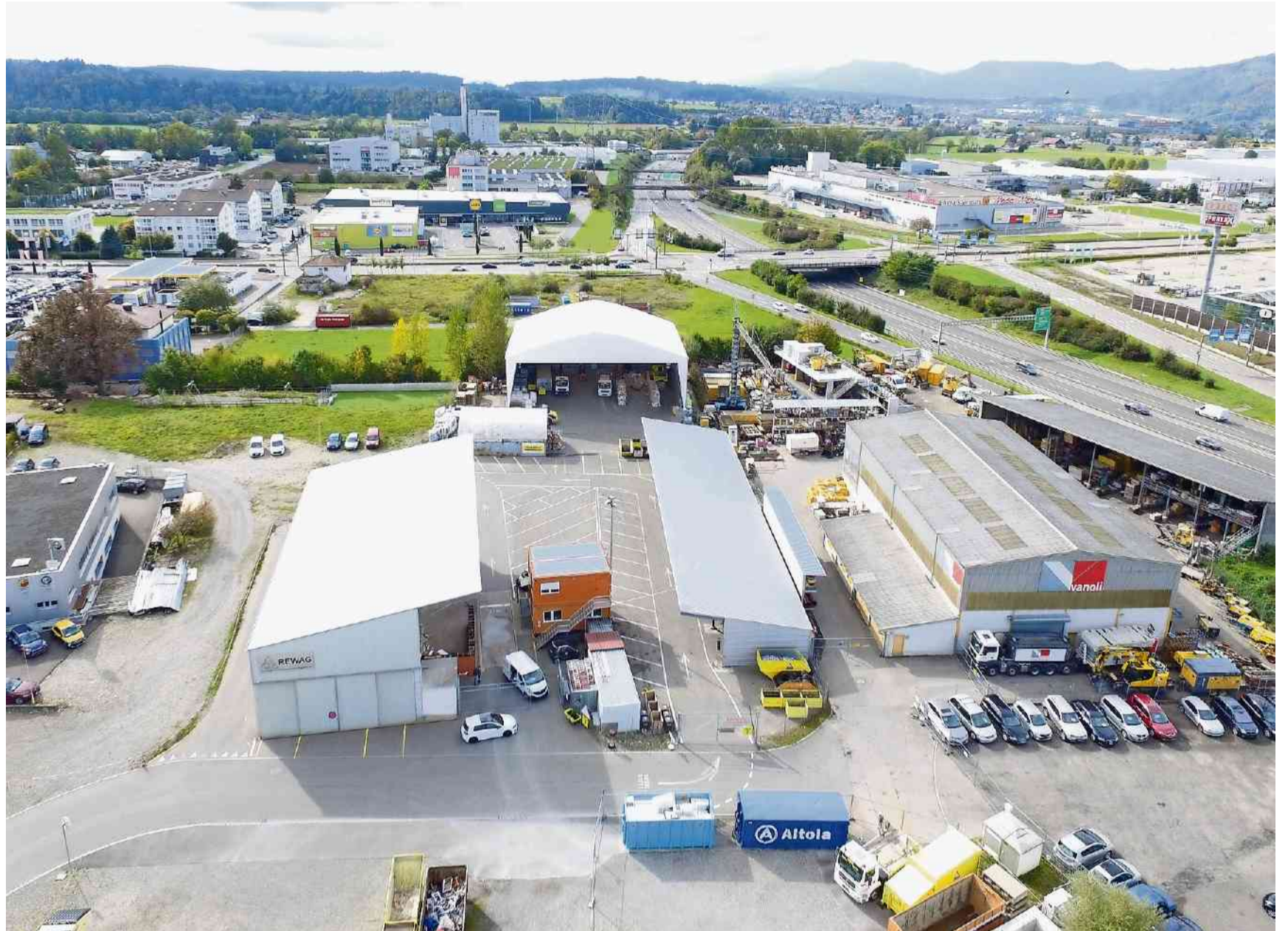
Das Gelände der REWAG (hintere Halle, Bildmitte und unten) will die neue Eigentümerin, die Paprec Schweiz AG, mit einer weiteren Halle bebauen.
